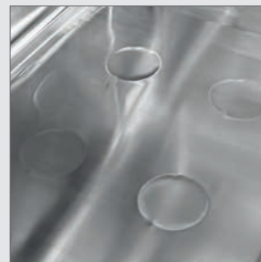
Cámara completamente revestida con lámina con cámara texturizada.
